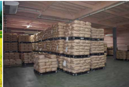
新精米ラインと同時に稼働した保冷倉庫
