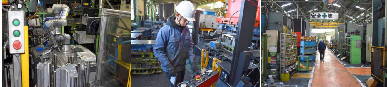
フェンダーエプロン生産に導入した協働ロボット 自動化を検討するプレス工程 生産現場は安全第一
